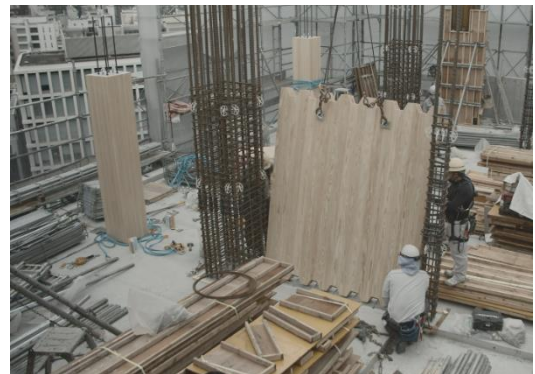
プライド神田駿河台工事風景
