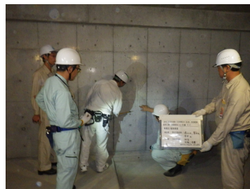
建設現場における品質管理検査
