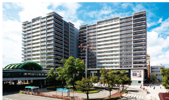
プラウド阪急塚口駅前 (2022年8月竣工)
