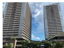
▲プラウドタワー武蔵小金井クロス
