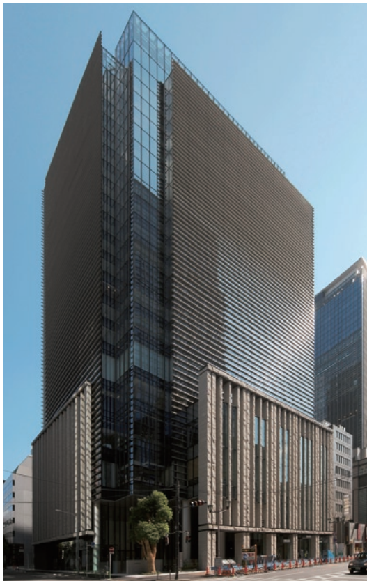
日本橋室町野村ビル 外観
