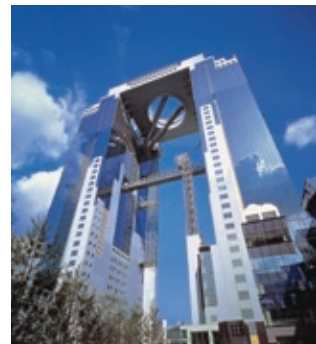
梅田スカイビル 所在地：大阪市北区 延床面積：160,094 m 2 (当社持分：28,251 m 2 )
