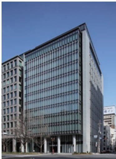
御堂筋野村ビル 所在地：大阪市中央区 延床面積：20,963 m 2
