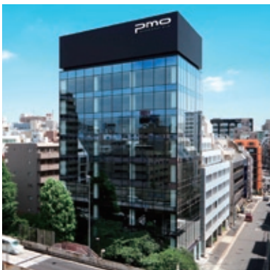
PMO日本橋本町
