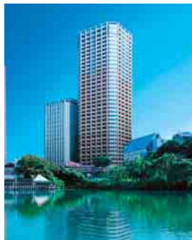
プラウドタワー千代田富士見 所在地:東京都千代田区 総戸数:414戸(当社持分306戸) 竣工:2009年2月予定
