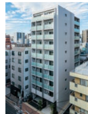
プラウドフラット上野松が谷
