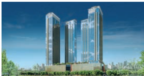
MITSUKOSHI BGC (低層商業部分) ※外観イメージ
