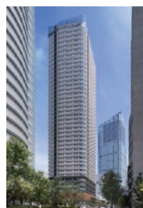
愛宕地区第一種市街地再開発事業 F地区 所在地：東京都港区 規模：地上41階、地下2階 延床面積：約54,100㎡ 主用途：住宅、オフィス、店舗他
