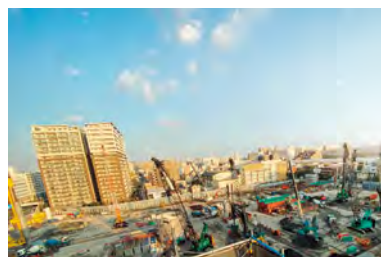
開発中の現場風景
