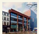
(現在)建物外観
