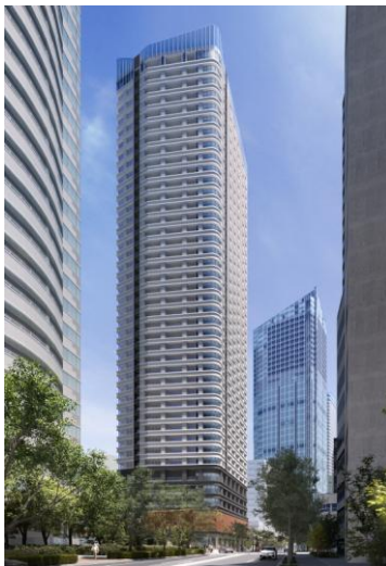
プライドタワー愛宕虎ノ門
