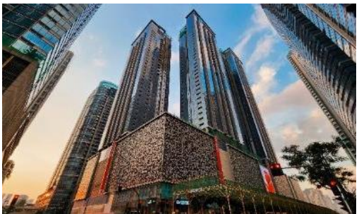
ザ・シーズンズ・レジデンス（マニラ） 竣工時期 2022年～（一部竣工済み） 主用途 分譲住宅、商業施設 総戸数 約1,300戸
