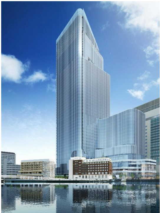
日本橋野村三井タワー
