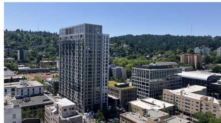
プレスブロック・プロジェクト（オレゴン州ポートランド） 竣工時期 2025年（竣工済み） 主用途 賃貸住宅、オフィス、商業施設 総戸数 341戸
