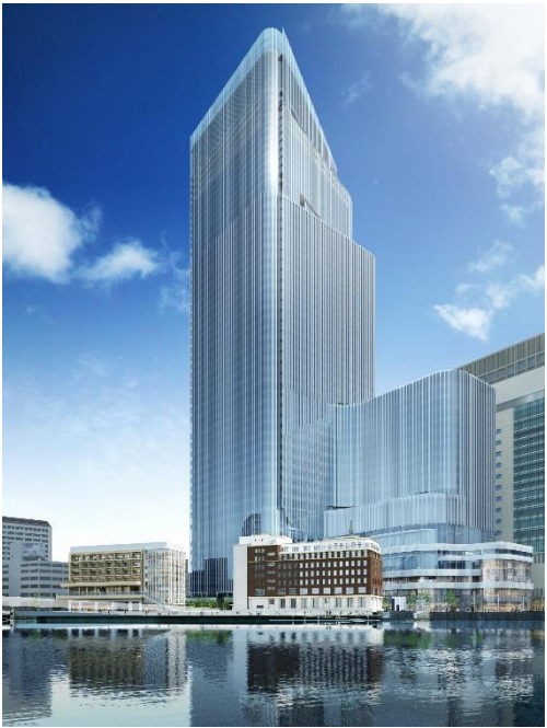
日本橋野村三井タワー
