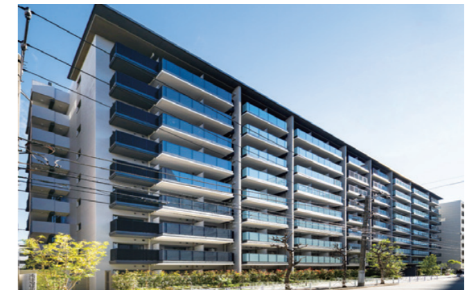
プラウドフラット南国サウス
