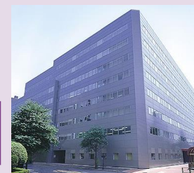
NOF日本橋本町ビル
