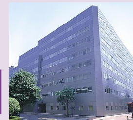
NOF日本橋本町ビル
