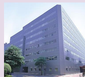
NOF日本橋本町ビル
