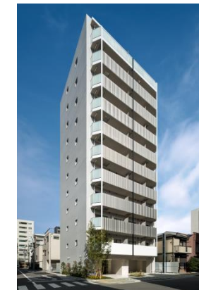
ブラウドフラット浅草橋
