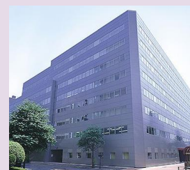
NOF日本橋本町ビル
