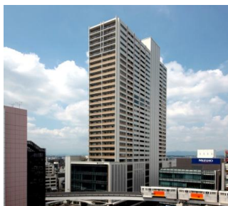
プラウドタワー立川 総戸数：292戸 計上期：17/3期
