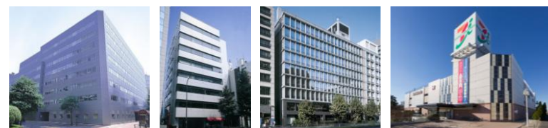
NOF日本橋本町ビル
