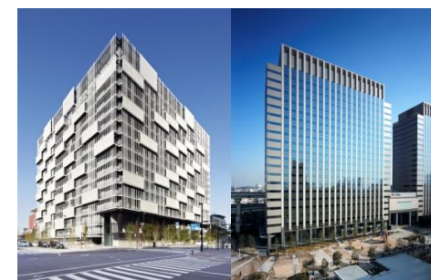
ラゾーナ川崎東芝ビル 深川ギャザリア タワーN棟
