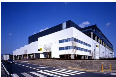
ランドポート厚木 延床面積：17,945坪、竣工時期：2007年4月
