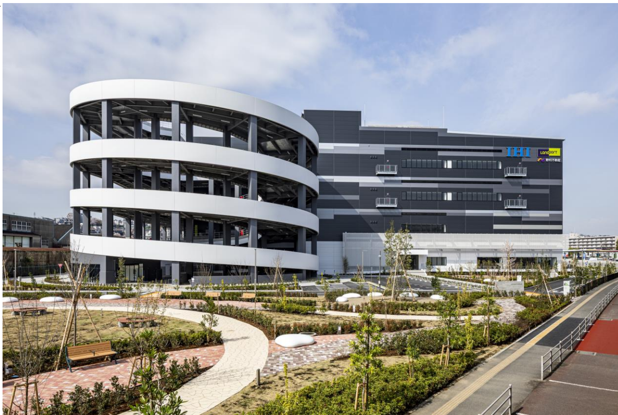
Landport Yokohama Sugita
