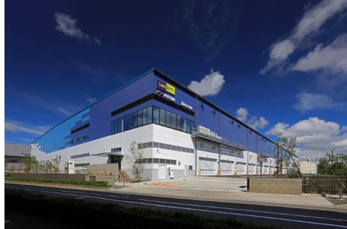
Landport Yokohama Fukuura
