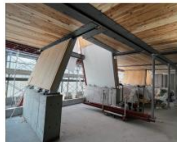
CLT・鉄骨ハイブリッド構造 施工中
