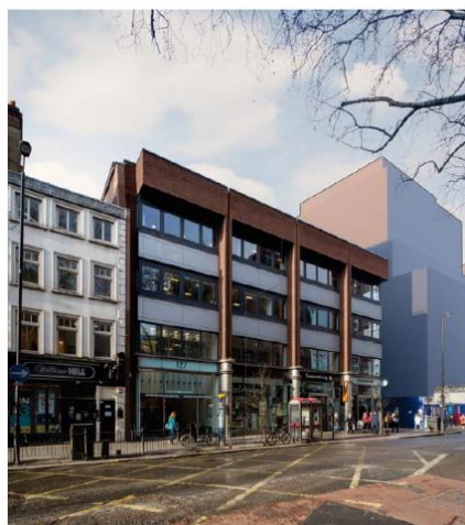
（現在）建物外観
